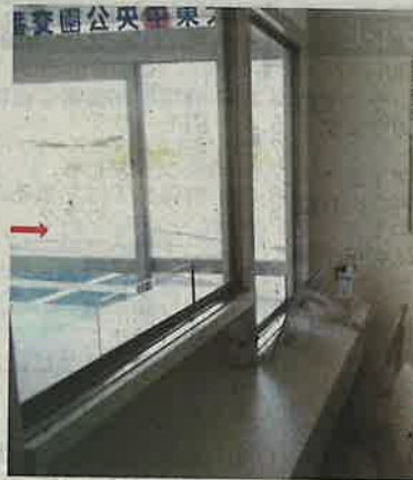
↑遮蔽板が設置された大阪府警大東中央公園交番(府警提供)
